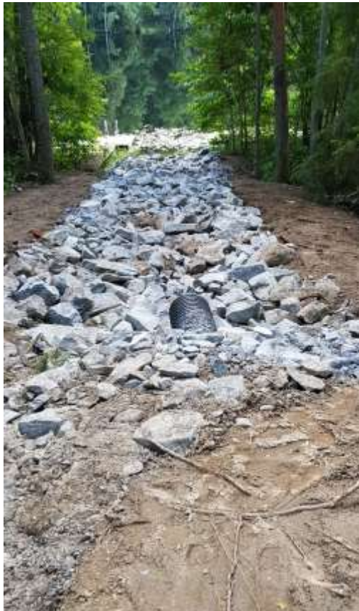
Kuva 9. Hulevesiratkaisu Pitkäjärven rannalla v. 2021
