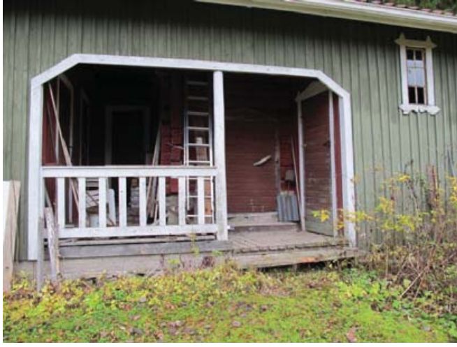
Rakennuksen länsisivun avokuisti ja siitä näkyvät vanhan aitan ovet ja hirsiseinät.
