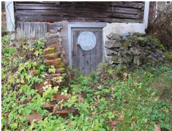
Piharakennuksen länsipäädyn ovi.
