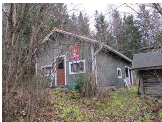
Talusrakennuksen pohjoispääty. Oikealla aitan (rakennus 003) kulma.
