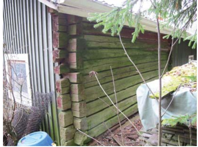
Taloustrakennuksen takaosassa (itäpuoli) näkyvissä on vanhan aittarakennuksen hirsiseinä. Aitta sijoittuu taloustrakennuksen eteläpäätyyn.
