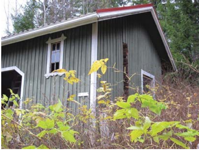
Rakennuksen eteläpäädyssä näkyvät vanhan aittarakennuksen nurkkahirret.
