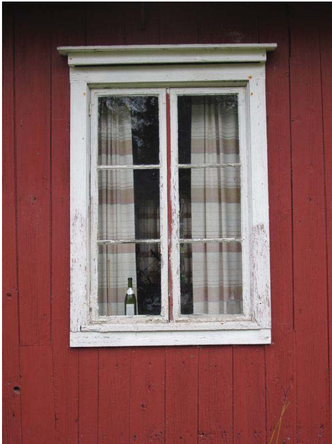
Eteläsivun (etupuoli) ikkuna.
