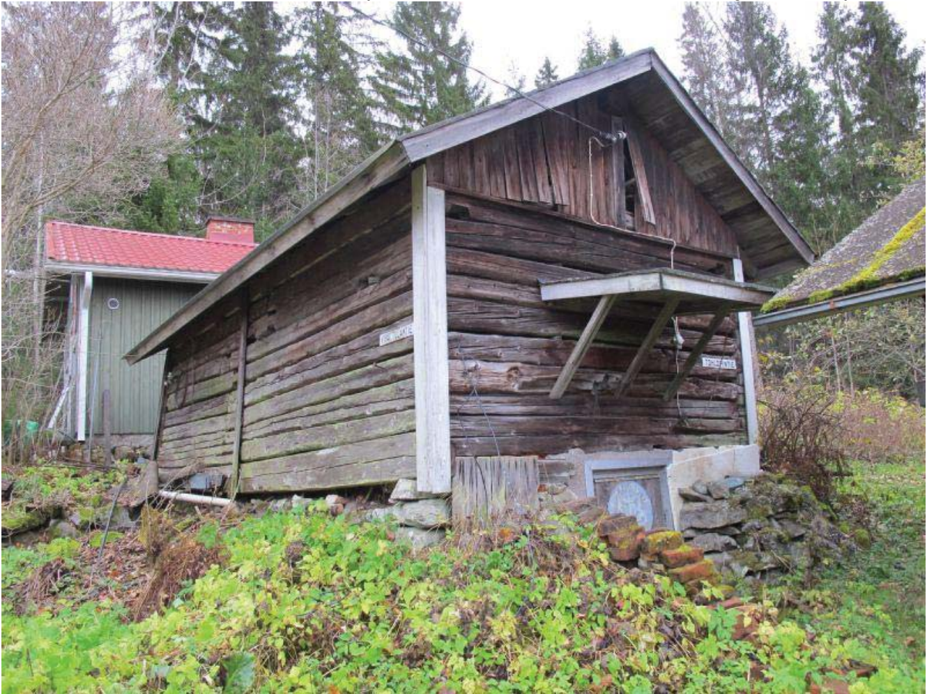
Pihan keskellä, kohti itää nousevassa rinteessä sijaitseva hirsinen aittarakennus. Rakennuksen länsipäädyn sisäänkäynti. Itäpäädyssä on oviaukko puuvarastotilaan.
