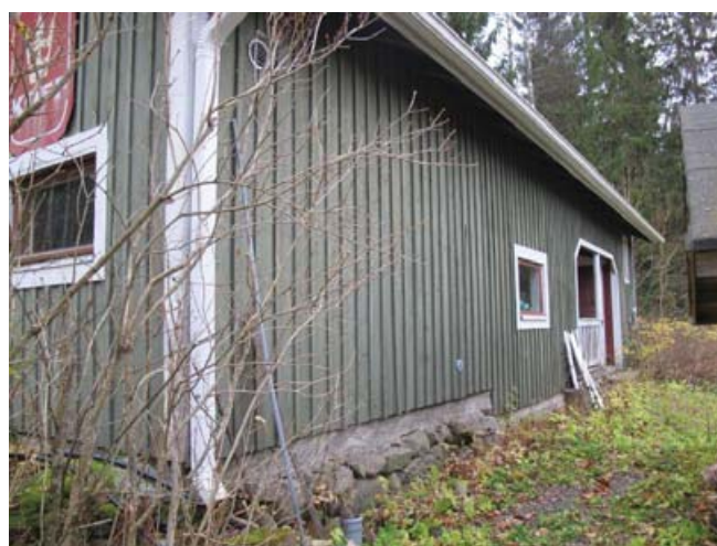
Talusrakennuksen länsisivu kohti pihaa.
