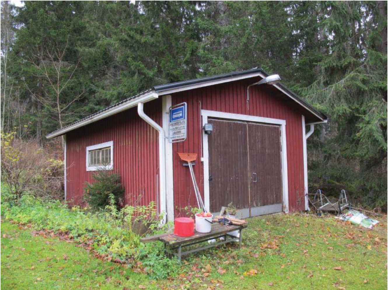
Tontin eteläsivulla oleva varastorakennus tai autotalli.
