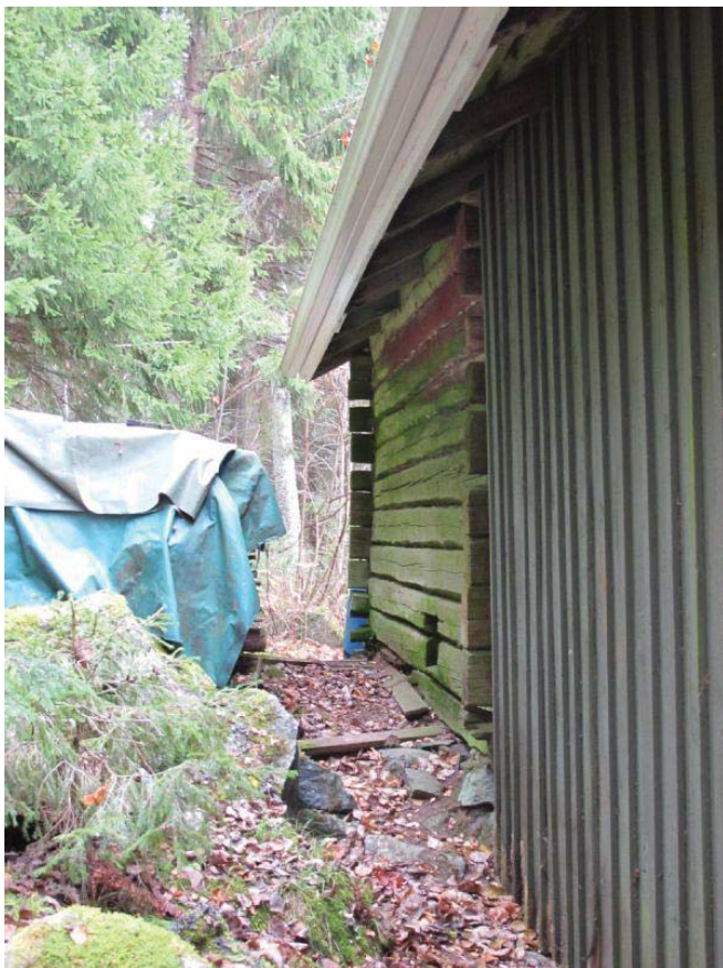
Rakennuksen itäseinä lähellä tontin rajaa.
