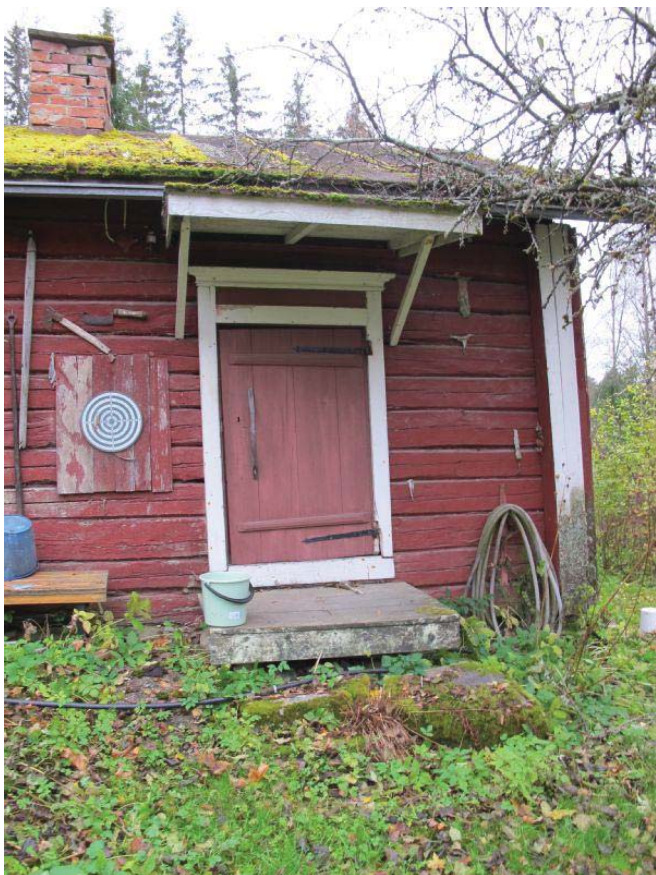
Taloustrakennuksen pohjoissivun länsipäädyn ovi, jossa on myöhemmin lisätty lippakatos.
