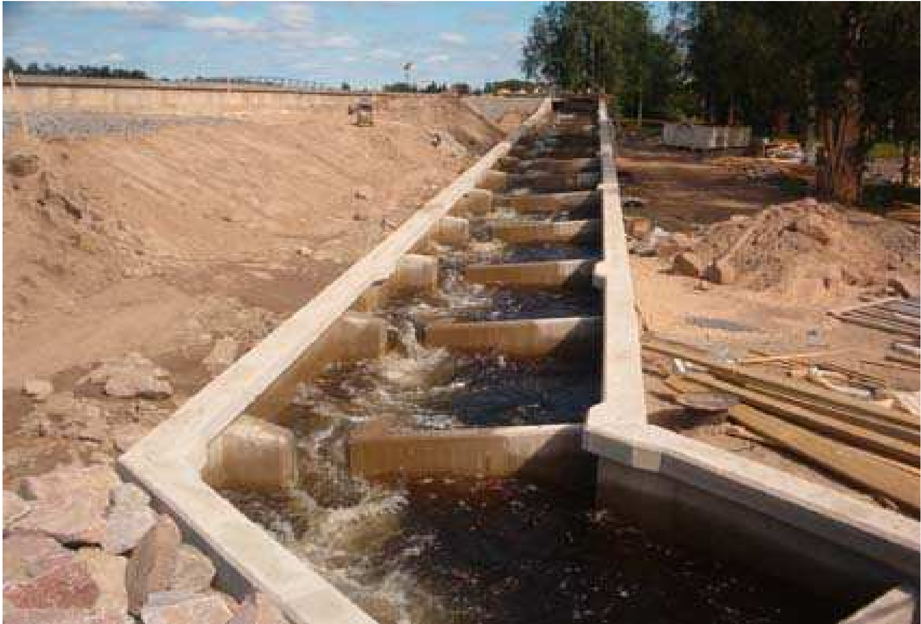
Rakenteilla ollut kalaporras Merikosken voimalaitoksella Oulussa vuonna 2003
