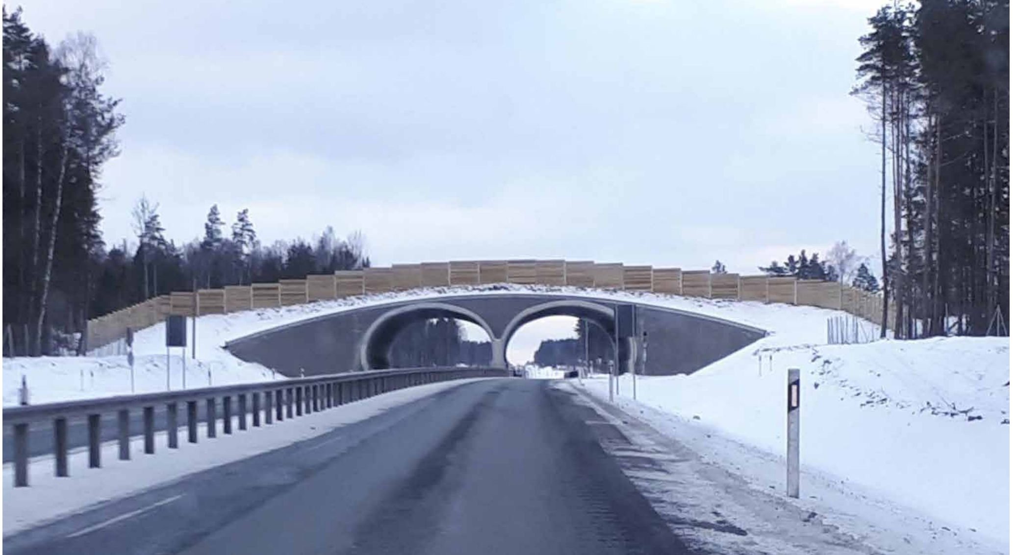
Kuva 32. Vihersiltaesimerkki Via Balticalla Virossa. Mitä leveämpi silta on, sitä useampi eläinryhmä voi sitä käyttää. Eläinten kannalta toimivan vihersillan minimileveyssuositus on 40-50 m (kts. Väre ym. 2003) (Kuva Sinikka Rantalainen).
